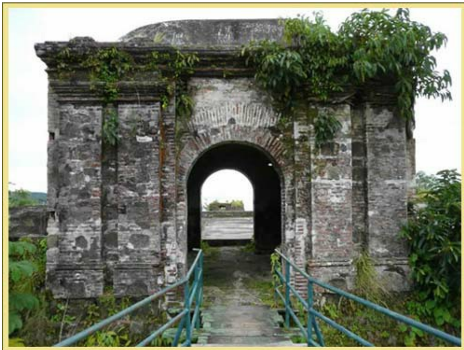
San Lorenzo del Chagres, il particolare dell'ingresso
